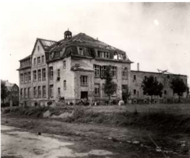
Auch die Schule Lehnstraße hatte große Schäden
