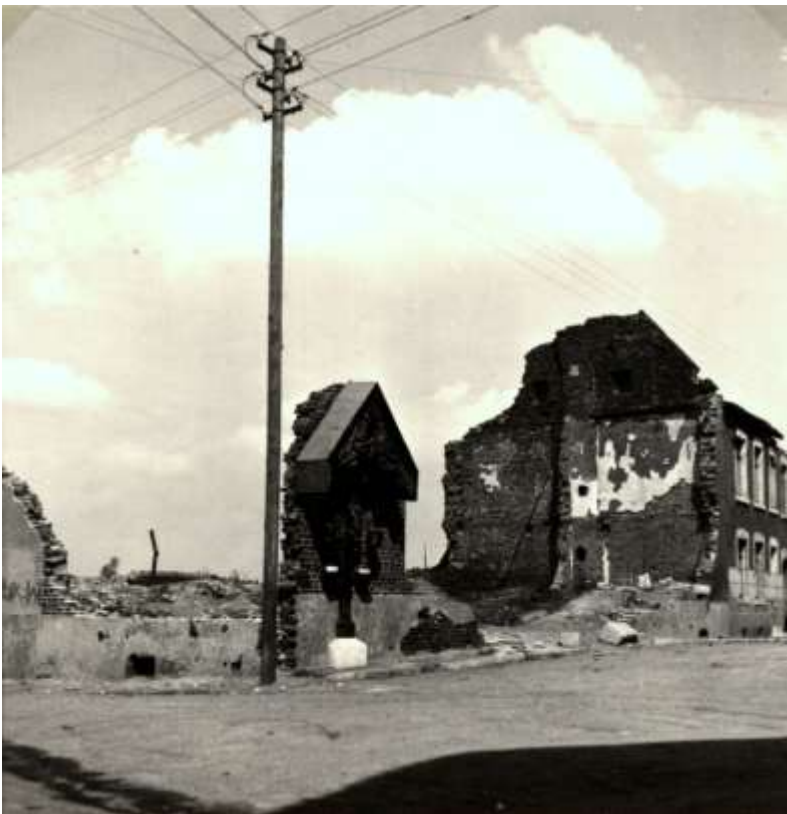
Zerstörte Häuser, hier Ecke Nordstraße/Elchenrather Straße
